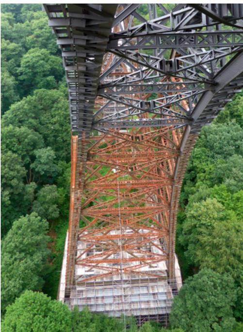
Ein Teil vom Brückenbogen. Die Korrosionsschutzarbeiten sind noch nicht komplett durchgeführt.
