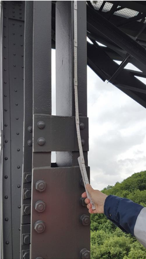
Johannes Jung führt das Aufmaß der Beschichtungsarbeiten detailliert durch und nimmt die Flächen der Platten auf.
